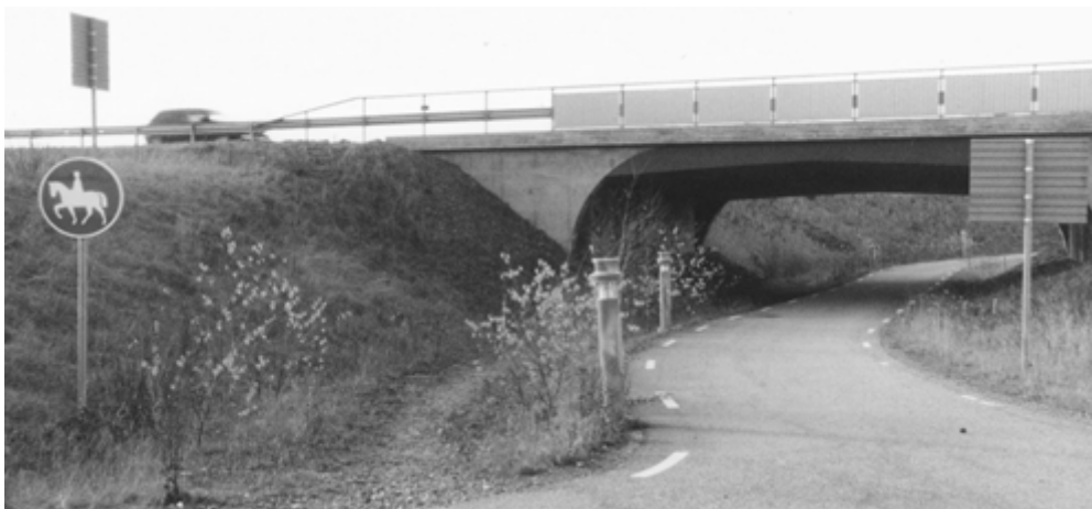
Figur 4. Ridstig kombinerad med cykelväg i tunnelunderfart
